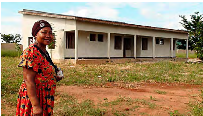
Parish Worker Ruth Mmari rakenteilla olevan Kimbilion edessä. Tansanian ensimmäisen naisten ja tyttöjen turvakodin rakennushanke alkoi vuonna 2012 ja se avattiin viisi vuotta myöhemmin. Tähän mennessä asiakkaita on ollut yli sata, suurin osa alaikäisiä.
